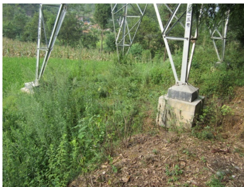
图 8-3 塔基区植被恢复情况
